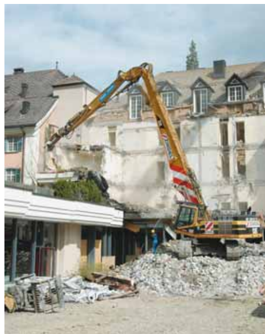
Mit einem Langarmbagger wurde der Mittelbau abgetragen.
